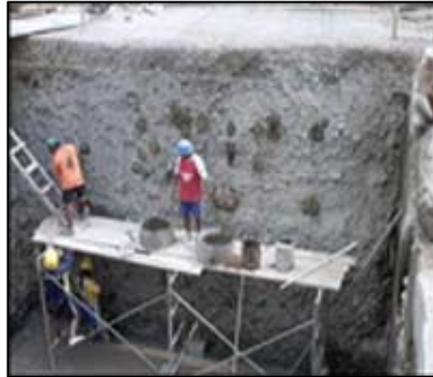
*Estabilización del talud con malla y mortero*
