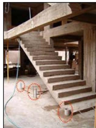
Tuberías de agua por un muro Inexistente
