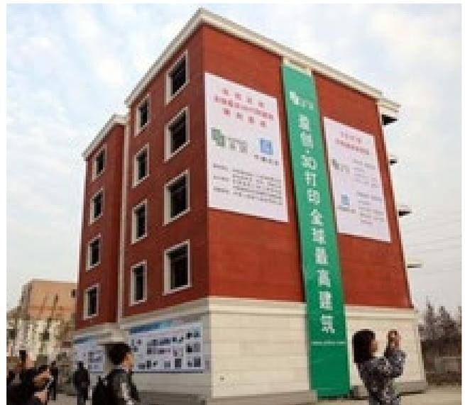
**Figura 8.** Edificio con elementos prefabricados por impresora 3D
