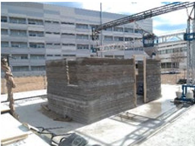
**Figura 4.** Impresora tipo puente grúa
