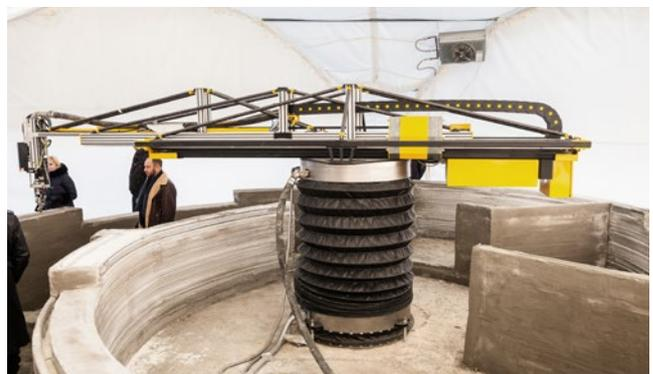
**Figura 7.** Impresora tipo brazo rotatorio
