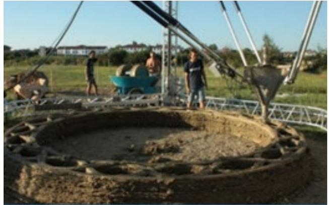
**Figura 5.** Impresora de cables suspendidos
