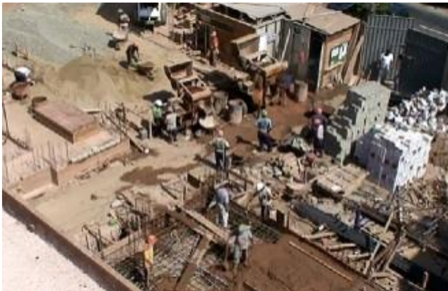
Figura 1. Vaciado de una platea de cimentación con concreto preparado en obra.
