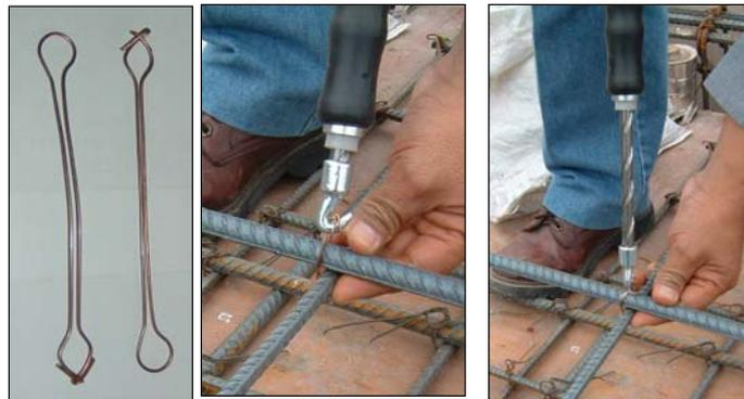
Fig. 7 Amarrado con Loop Ties y Twister Tool
