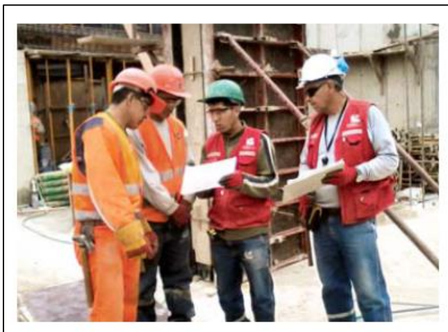
Figura 2. Llenado de ATS en la zona de trabajo
